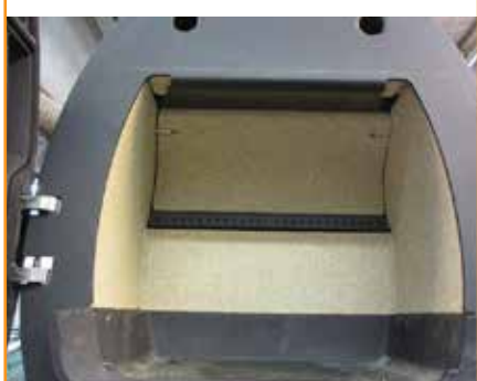
Brennkammeret er nå montert 22
